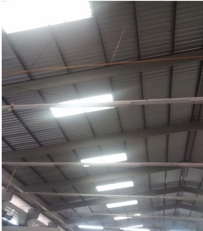
**Figura 4.** Placas translúcidas no telhado do pavilhão.
