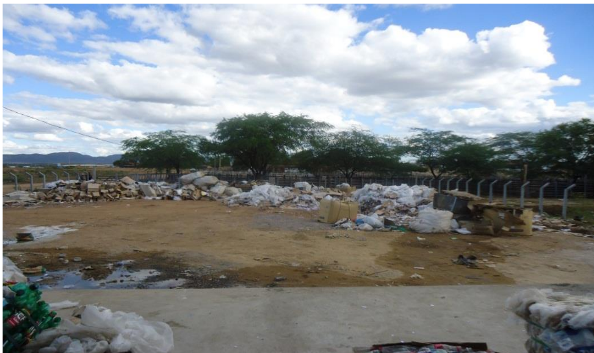
Figura 5. Separação do material antes da construção galpão
