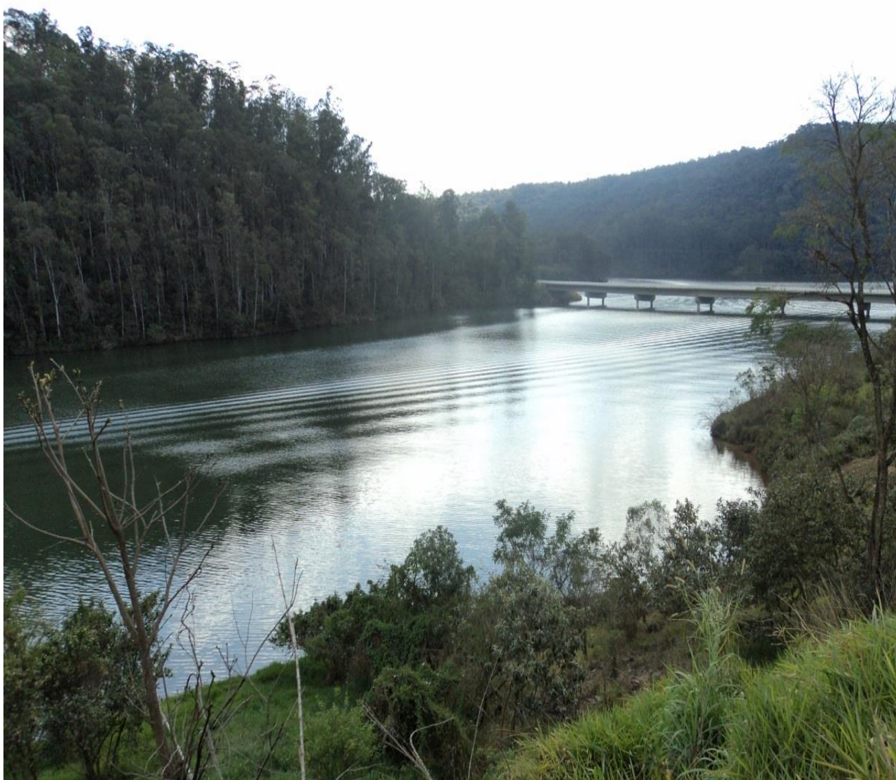
Figura 3. Foto da Ponte Santa Inês, Rodovia Prefeito Luiz Salomão Chamma.
