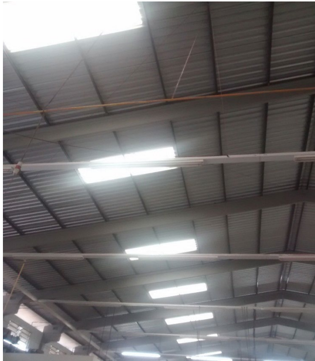
Figura 4. Placas translúcidas no telhado do pavilhão.
