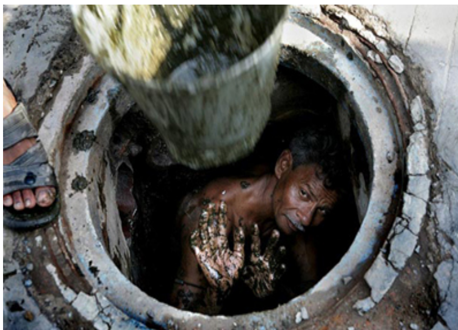
Figura 4: Trabalhador realizando serviço de limpeza em rede de esgoto, na Índia.
