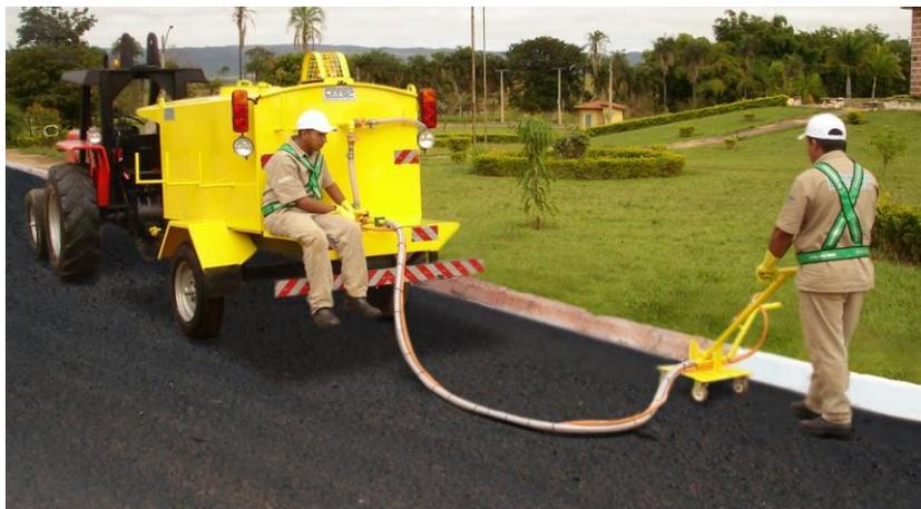
**Figura 3. Máquina utilizada para a pintura de meio fio**
