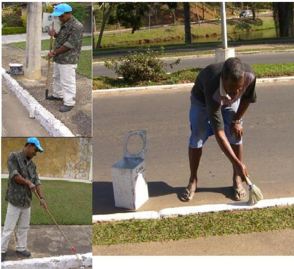
**FIGURA 6: Pintura de meio fio com o rolo e com o pincel.**
