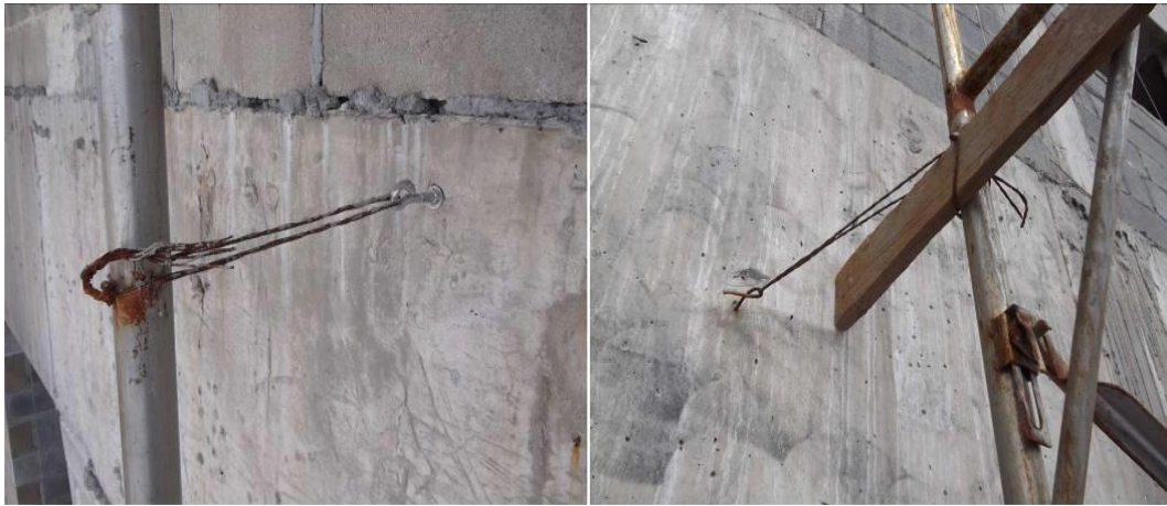
FIGURA 3. Fixação dos montantes na estrutura do prédio.
