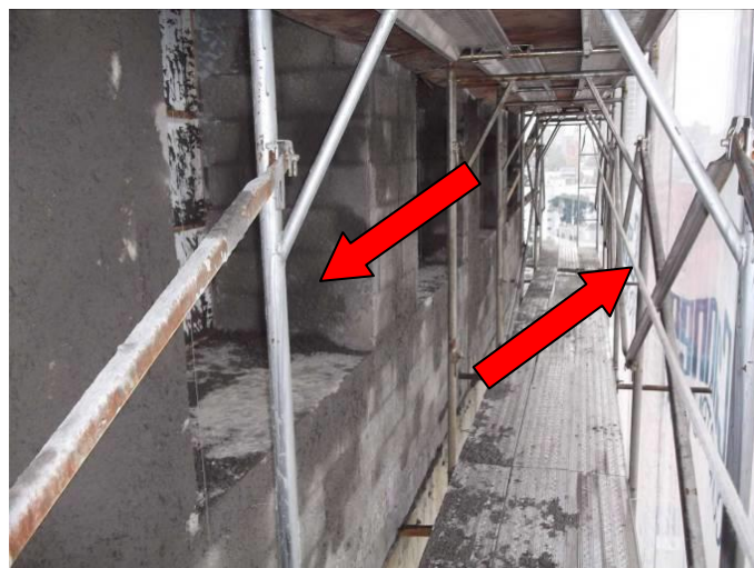
Figura 2. Contraventamento da plataforma.
