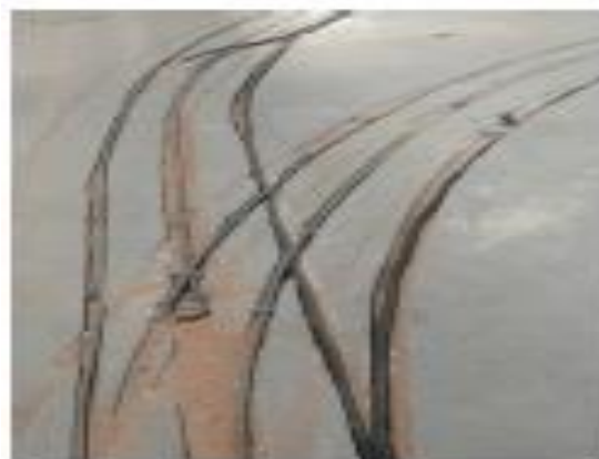
Figura 17 – Recorte no piso para instalação de cabos de indução Fonte: Adaptado de Dürr Brasil (2018)
