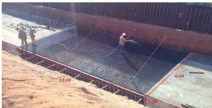
Figura 5 – Bloco sendo preparado para concretagem
