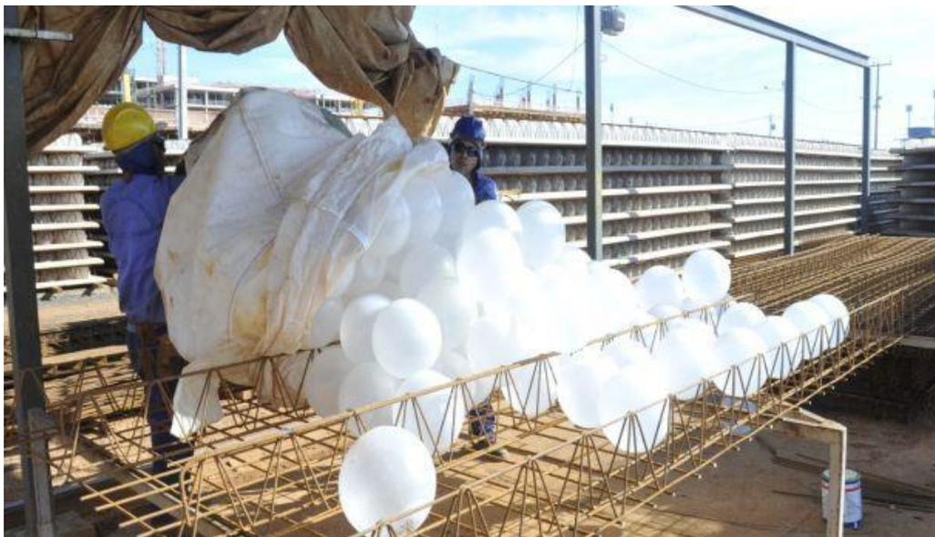
**Figura 3 – Posicionamento das esferas na armação.**
