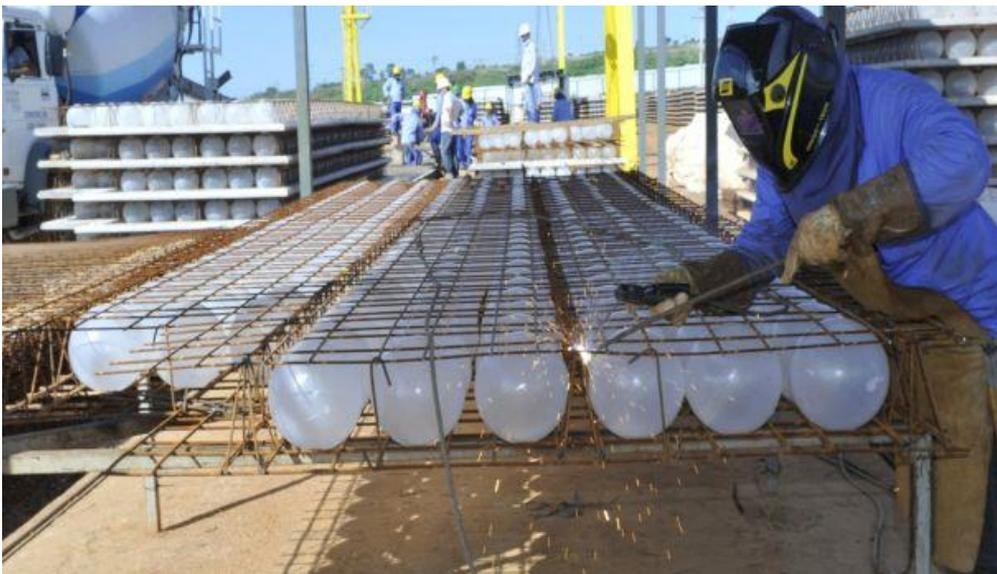
**Figura 4 – Soldagem da malha de aço superior**
