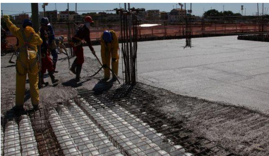
**Figura 6 – Processo de concretagem da laje.**
