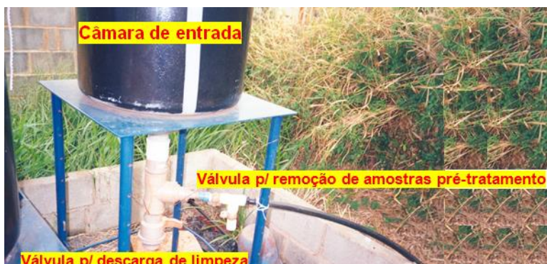
Figura 4. Vista detalhada da câmara de entrada do esgoto.
