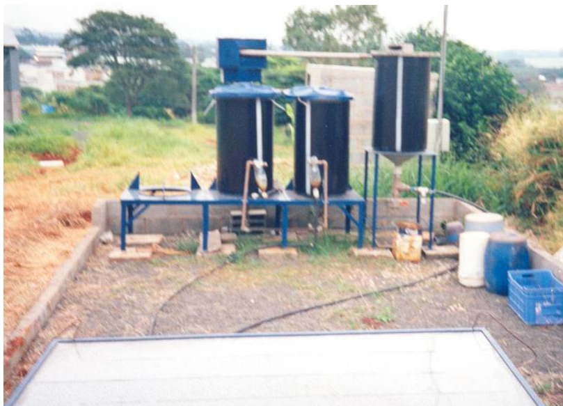
Figura 2. Vista da estação de filtro lento da FEAGRI
