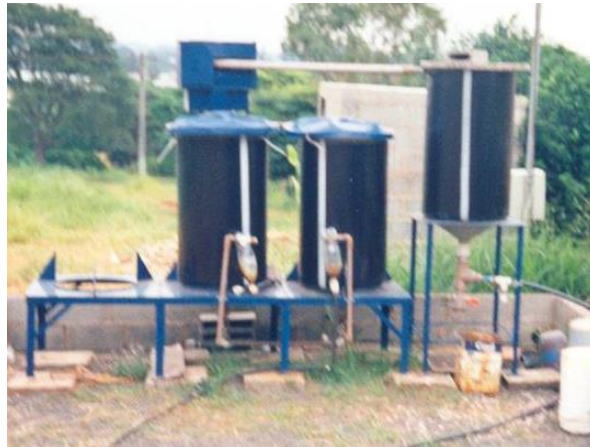
Figura 6: Vista da estação de filtro lento da FEAGRI.
