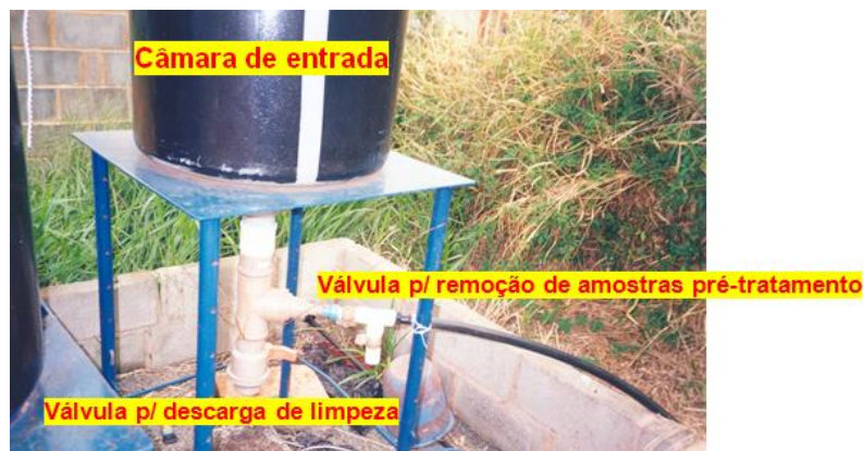
Figura 7: Detalhe da câmara de entrada.
