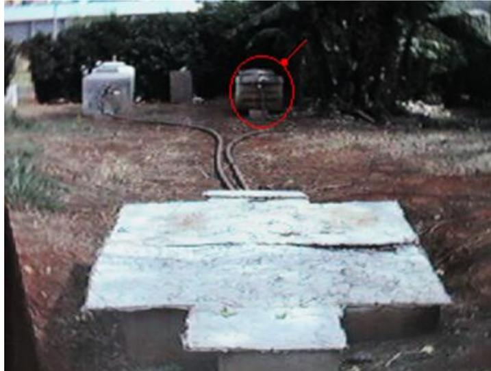
**Figura 5** – Caixa de areia onde é captado o esgoto para tratamento. Ao fundo em destaque o tanque séptico modificado.
