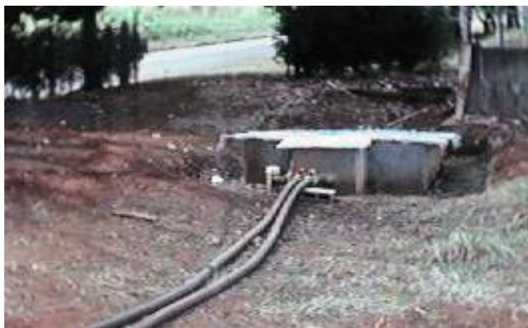
Figura 3: Vista frontal da caixa de areia com as mangueiras coletoras de água residuária.
