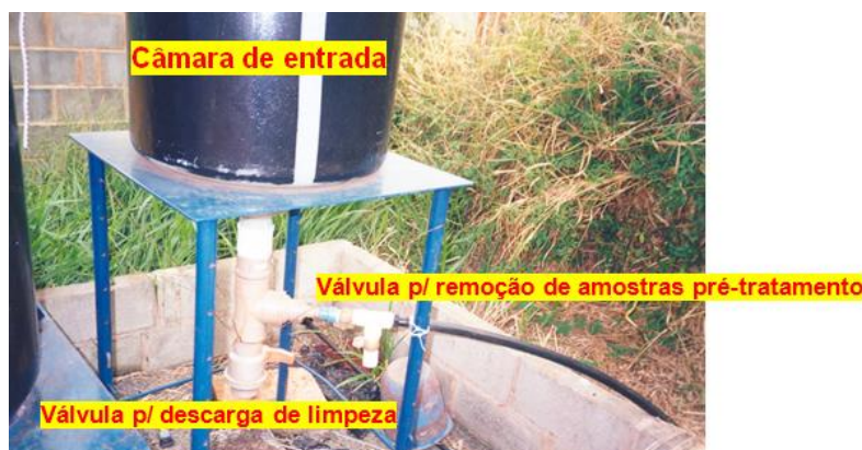
Figura 6: Vista detalhada da câmara de entrada do esgoto.
