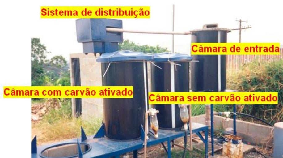
**Figura 2.** Vista da estação de filtro lento da FEAGRI. O tempo de tratamento é influenciado pela carga de detenção hidráulica ( $\theta_h$ ) que permiti estabilizar o esgoto doméstico. Dessa forma, sendo importante determinar a estimativa de estabilização a partir das características do projeto adotado.
