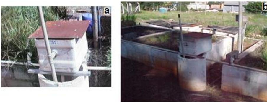
**Figura 4** – Vista da caixa de distribuição em 4a e vista dos wetlands em 4b.
