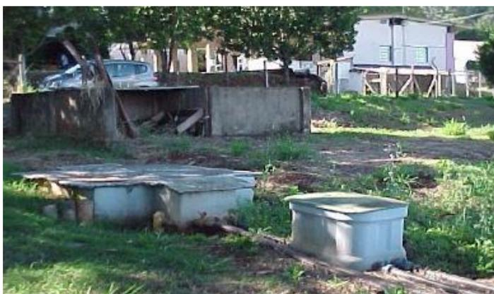
**Figura 2** – Caixa de passagem de esgoto.
