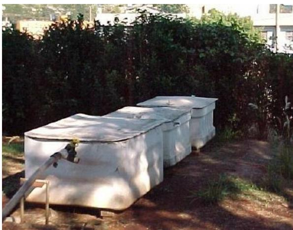
**Figura 3** – Tanque séptico para distribuição da água residuária (esgoto).
