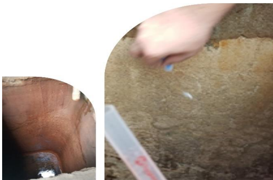
Figura 1. Reservatório de concreto pré e pós higienização
