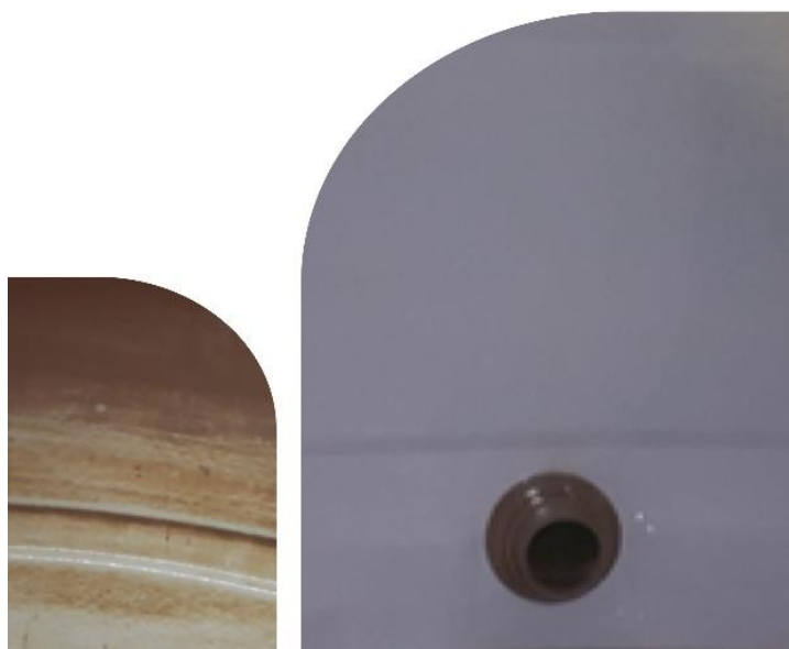
Figura 2. Reservatório PVC pré e pós higienização
