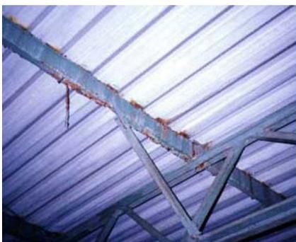
**Figura 3** – Corrosão galvânica
