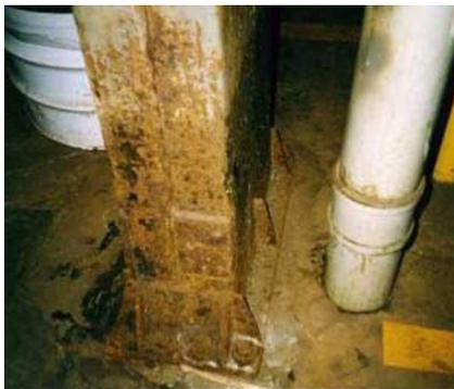
**Figura 2** – Corrosão em estrutura metálica
