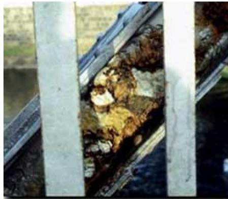
**Figura 4 – Corrosão por lixivação**
